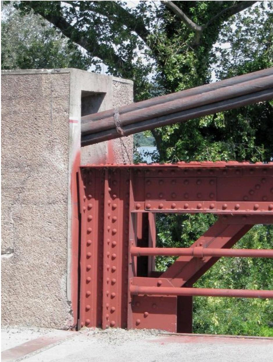
Massif d'ancrage, vue partielle : jonction avec le parapet (depuis la rive droite)
