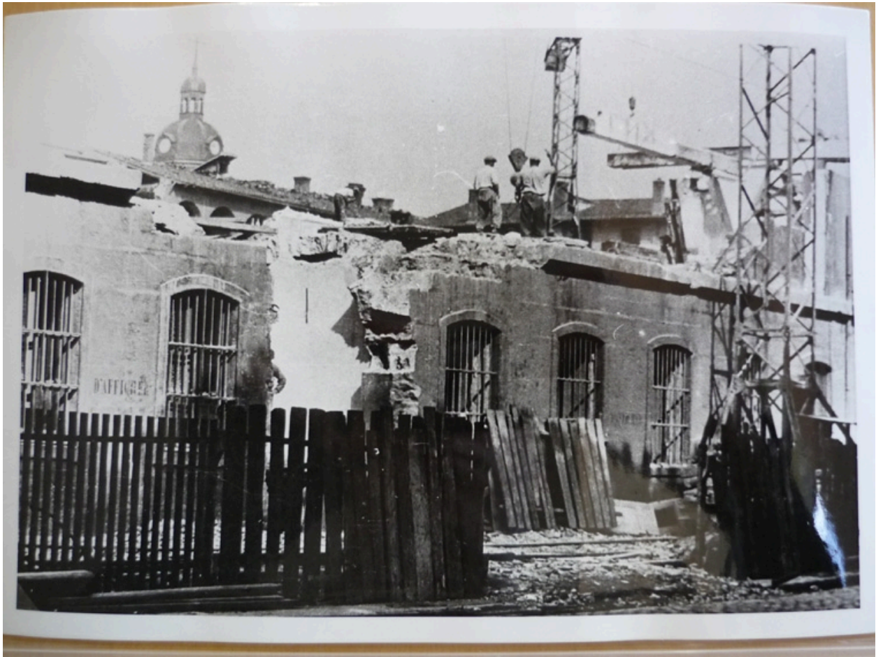
Démolition, 1934 . Photographie AC Lyon. 2PH31
