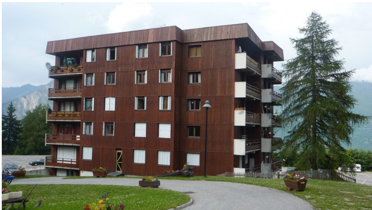
Vue générale depuis le sud-ouest
