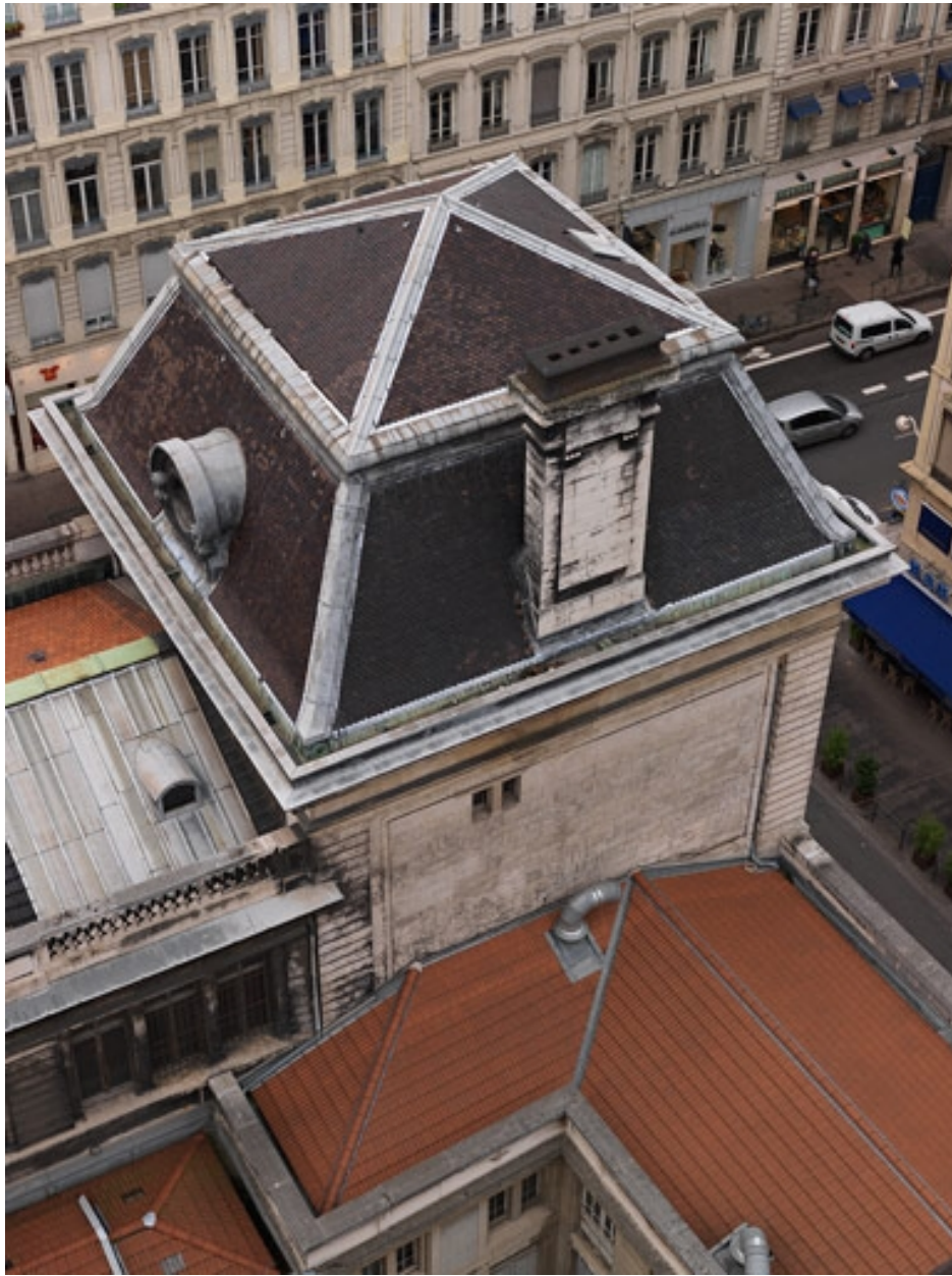
Bâtiment A'. Détail du pavillon à l'angle de la rue Bellecordière
