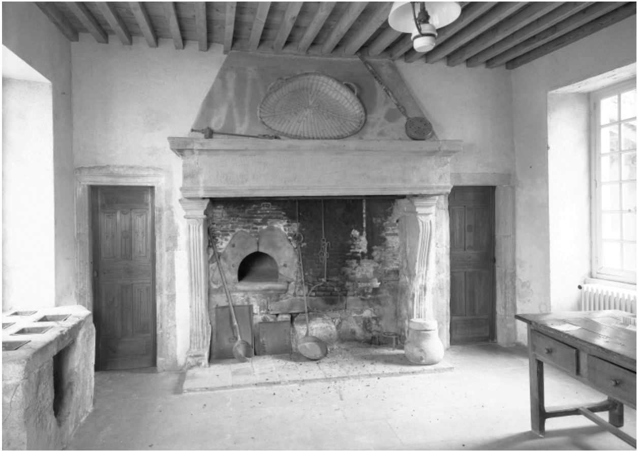
Corps de logis sud-ouest, rez-de-chaussée, ancienne cuisine : vue générale intérieure de la cheminée.
