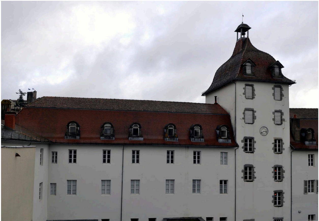
Bâtiment C : élévation sur cour, partie ouest et vue partielle du bâtiment A, en retour à gauche
