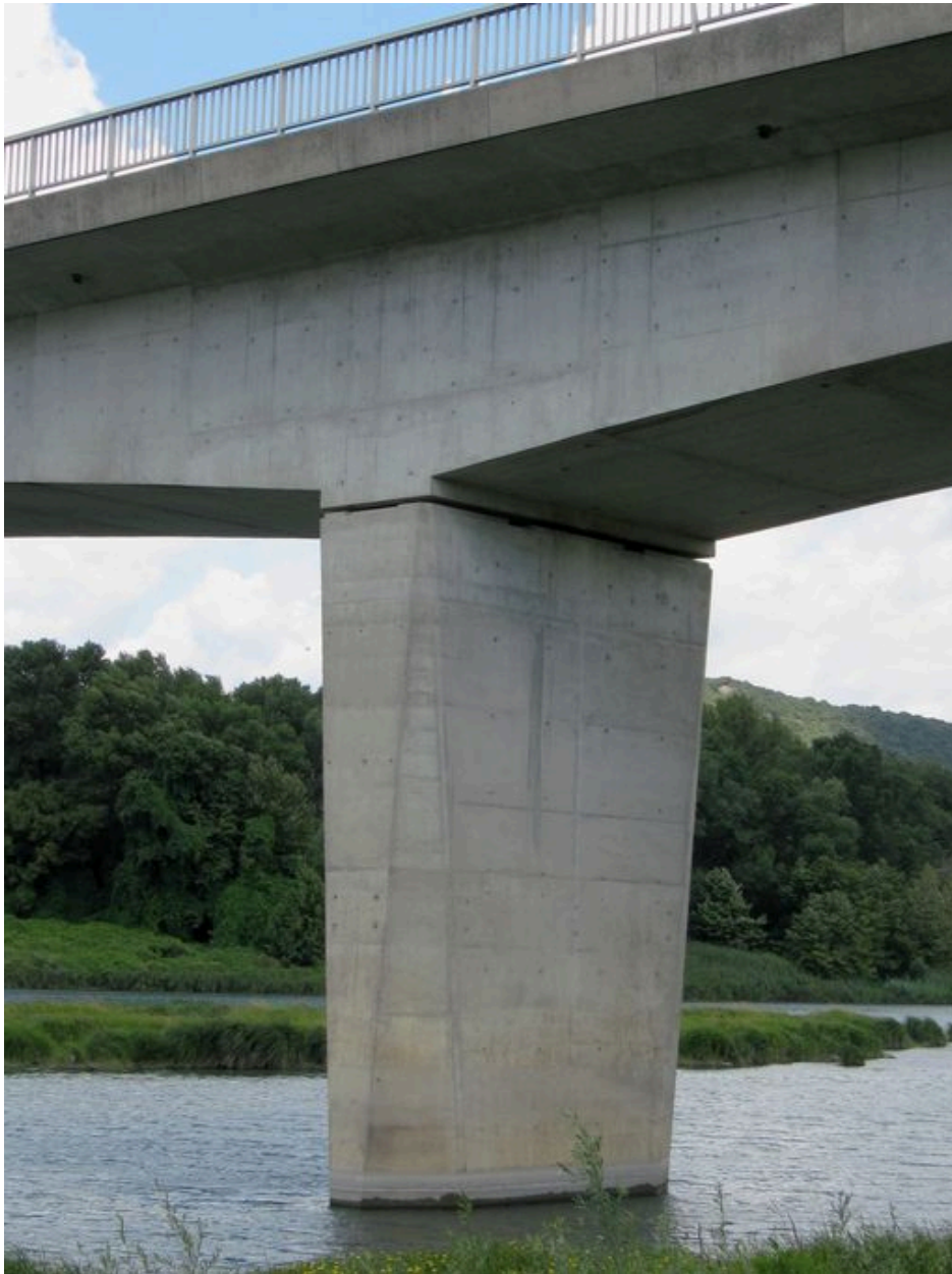
Pile, face aval (depuis la rive gauche)
