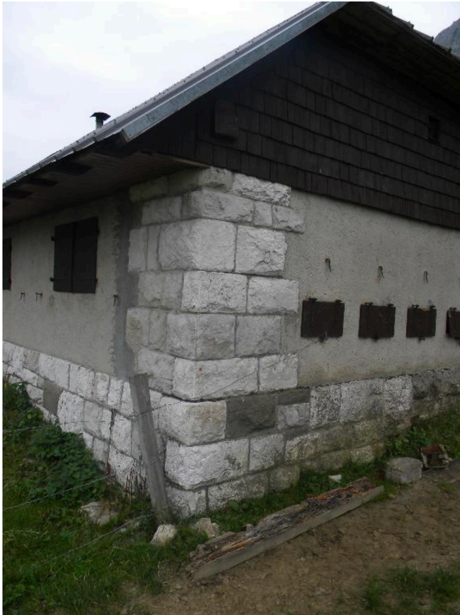
Détail d'un chaînage en pierre apparente.
