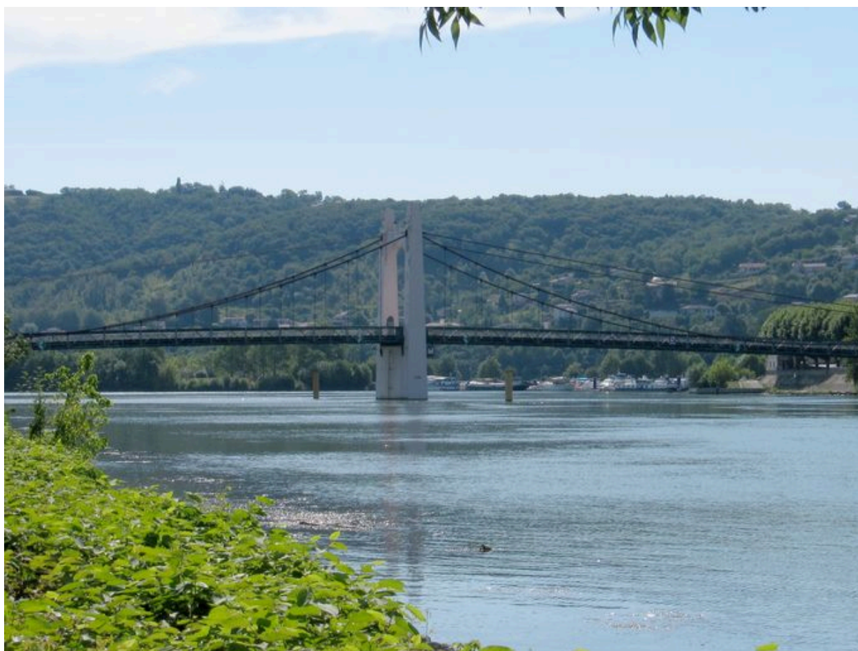
Vue partielle, face aval (depuis la rive droite)
