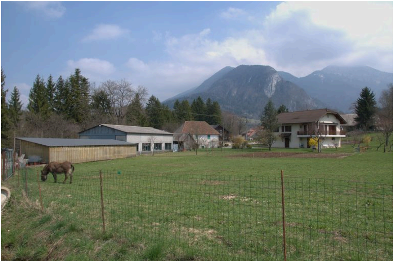
Vue d'ensemble du moulin
