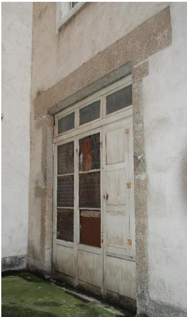
Détail de la façade sur cour
