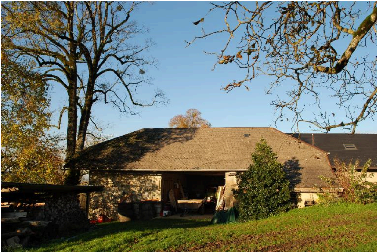
Vue d'ensemble de la façade sud des bâtiments agricoles annexes.
