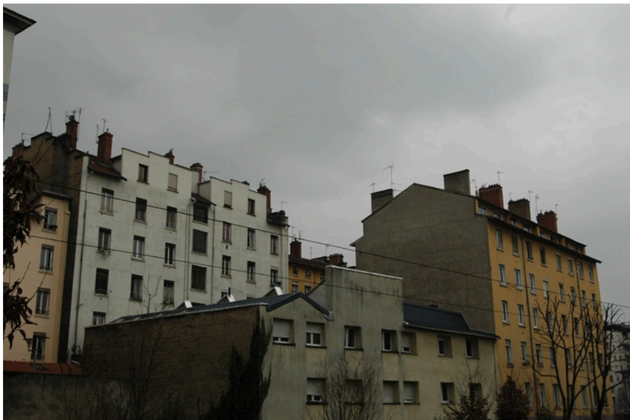
Façade arrière, sheds, vue nord est.
