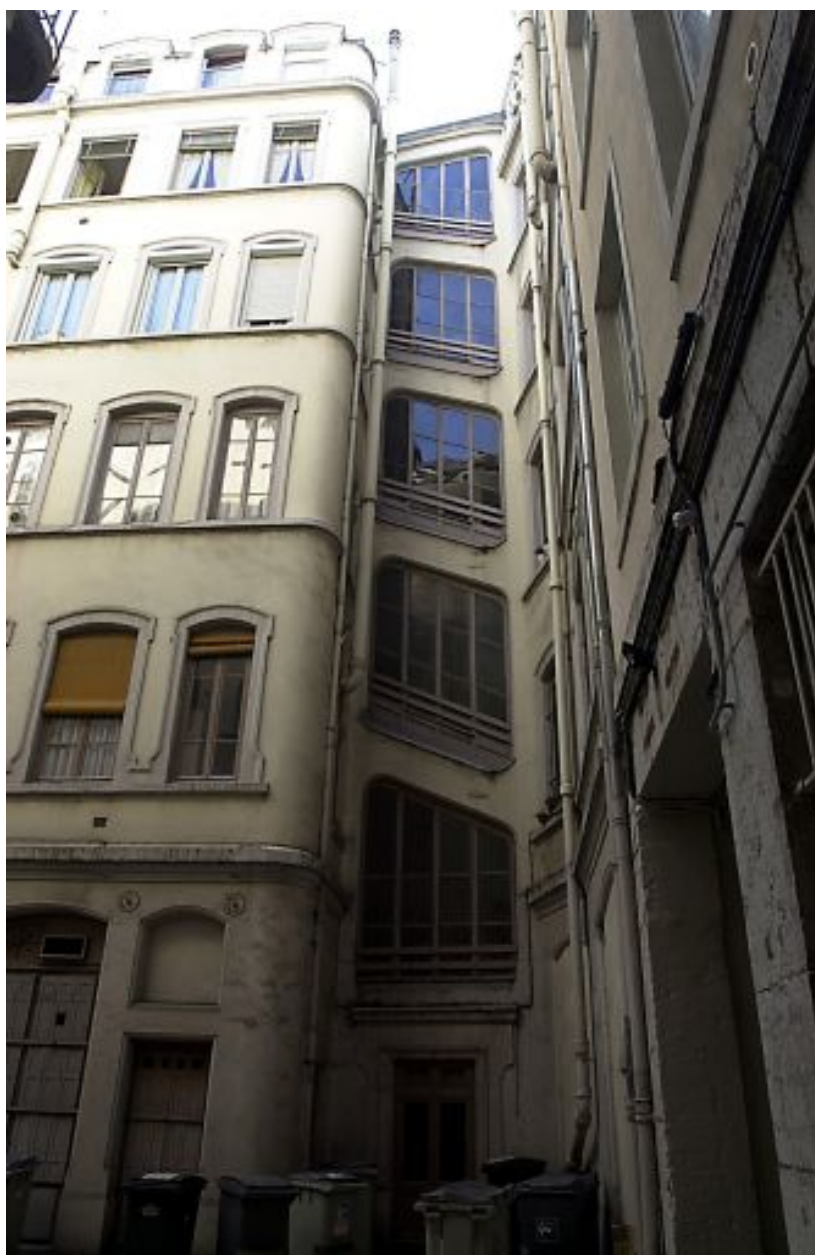
Elévation de l'escalier sur la cour commune
