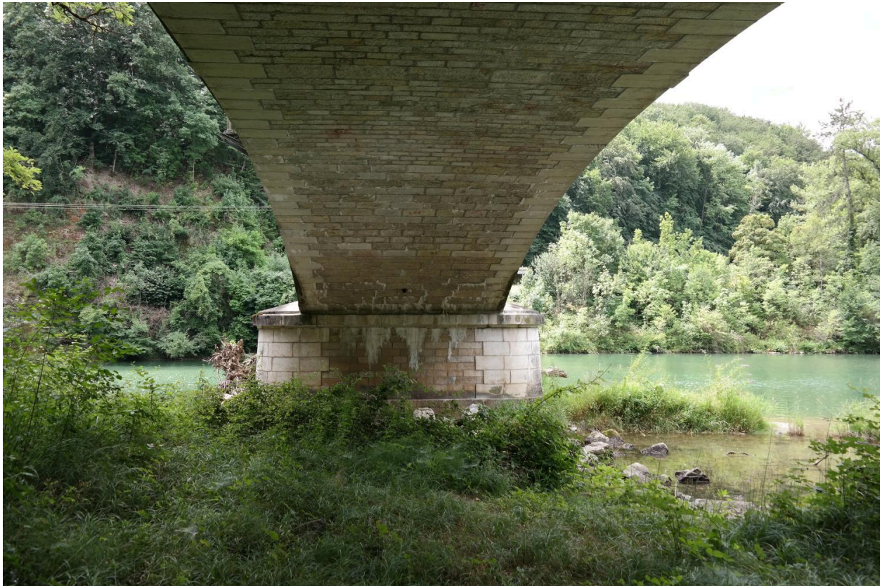
Pont du Fier. Intravoute et pile.
