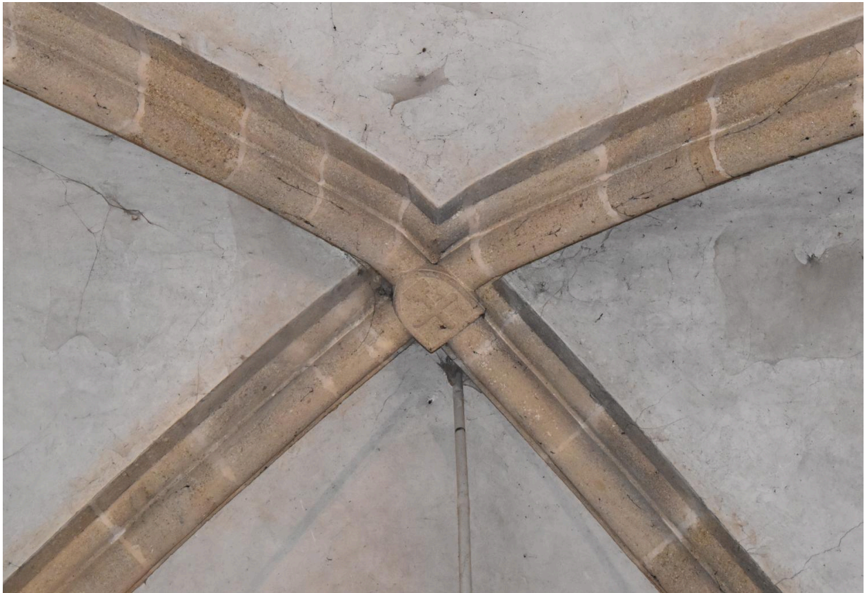
Détail de la croisée d'ogives à clef de voûte ornée d'une croix de la deuxième travée de la nef.
