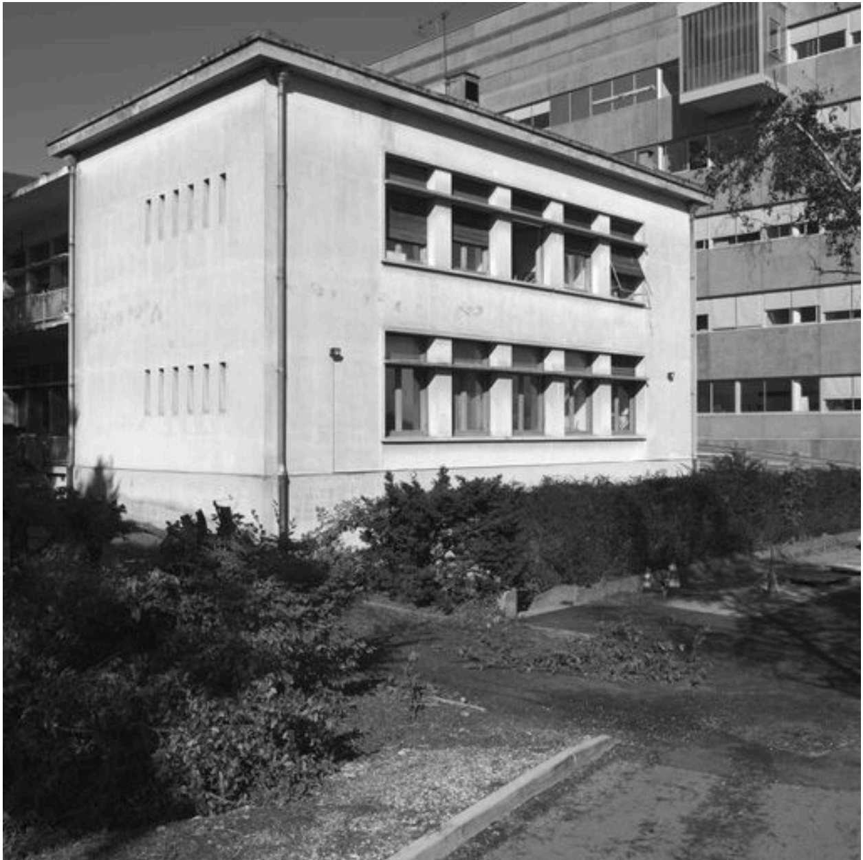
Bâtiment W, extrémité est de l'aile nord
