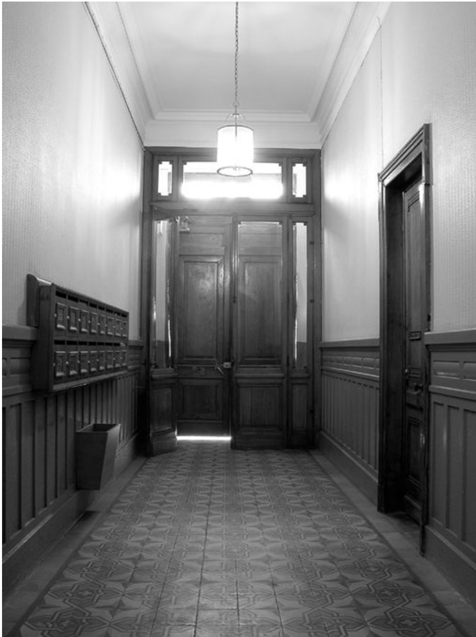
L'allée pourvue d'un sas ; sol revêtu de carreaux de ciment
