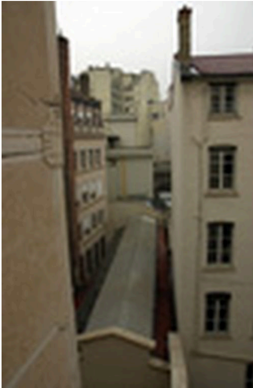
Vue de l'escalier du corps de bâtiment central
