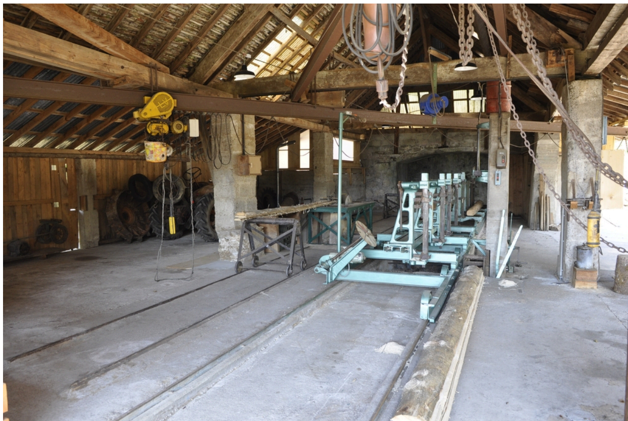
Vue d'ensemble intérieure.
