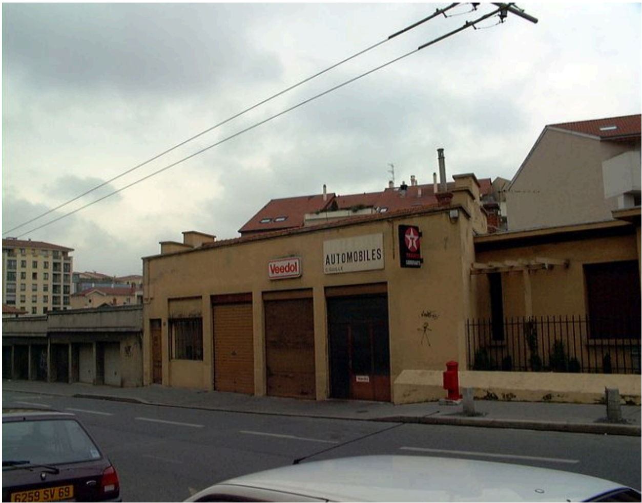
Vue générale, rue de Belfort
