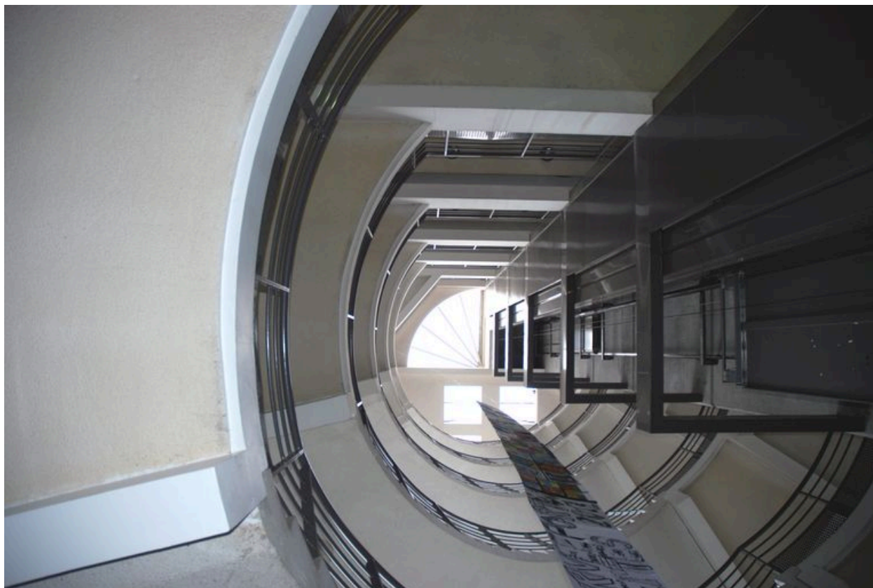
Bâtiment A : escalier vu depuis le bas
