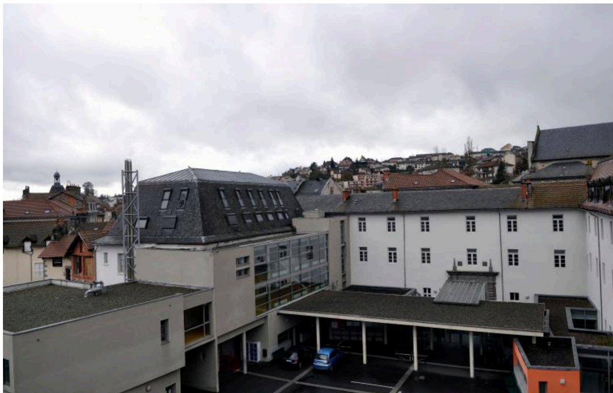
Cour, vue d'ensemble depuis le nord-est
