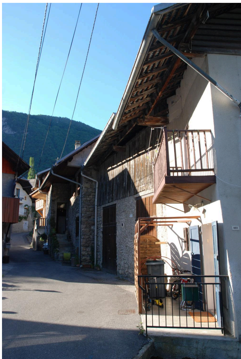
Vue de la rue de l'Otton depuis le sud.
