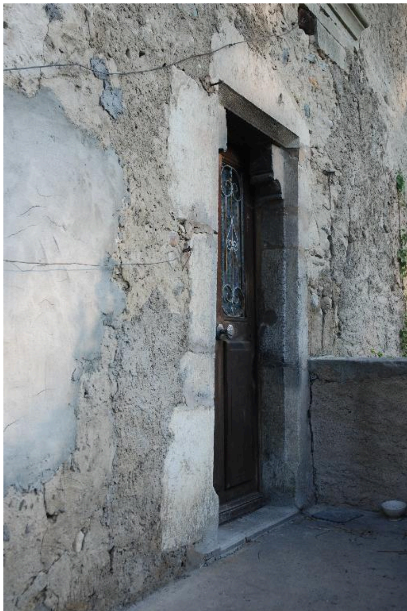
Détail de l'habitation : porte du rez-de-chaussée surélevé (linteau sur coussinets).
