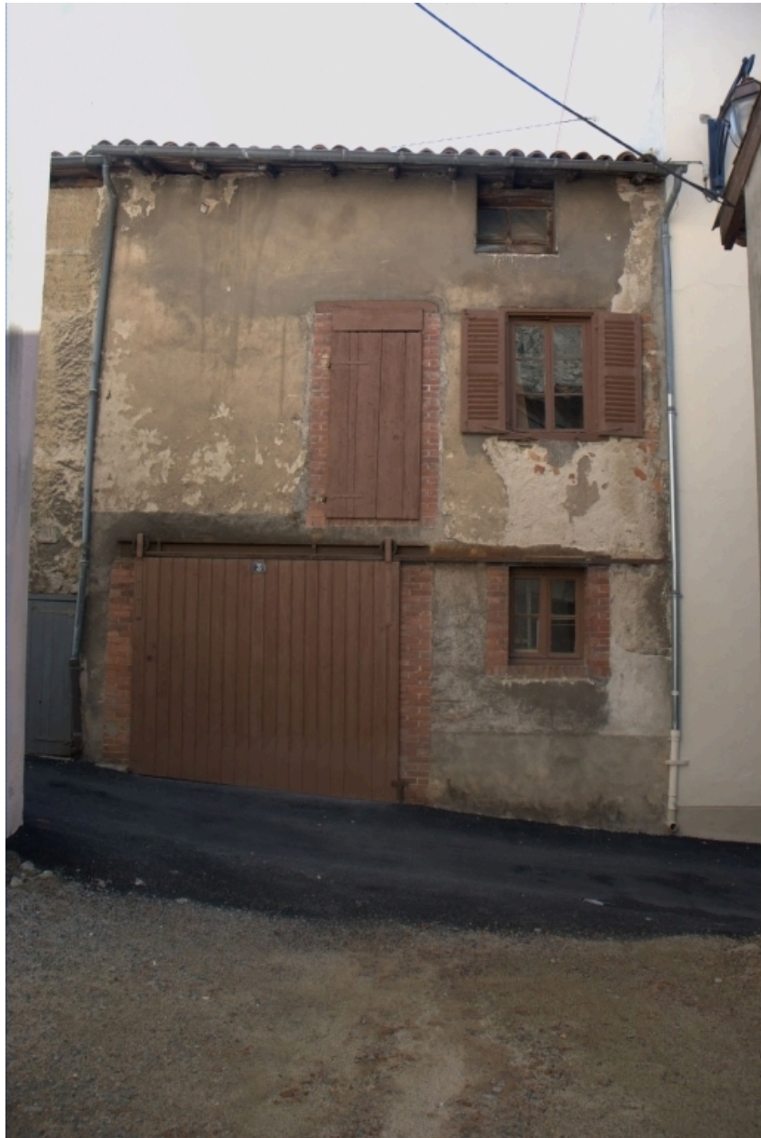
Îlot 3. Ecoles (rue des) 03. Vue générale de la façade sur rue.
