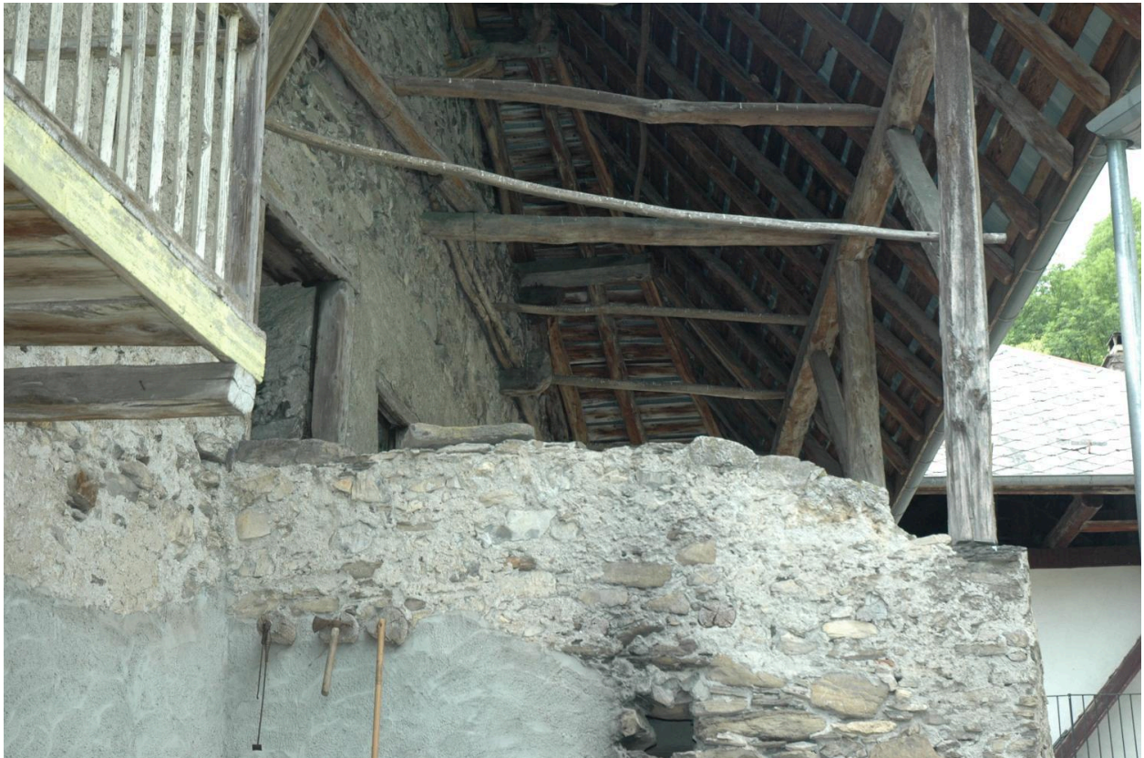
Maison de vigneron mitoyenne (2018 B 425), détail du massif de l'escalier et de l'avant-toit protégeant des perches pour le séchage.
