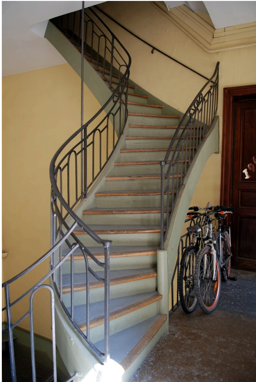
Escalier : volée des étages surélevés
