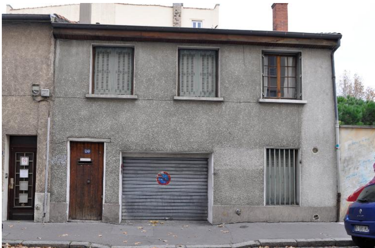
Bâtiment sur rue, vue générale
