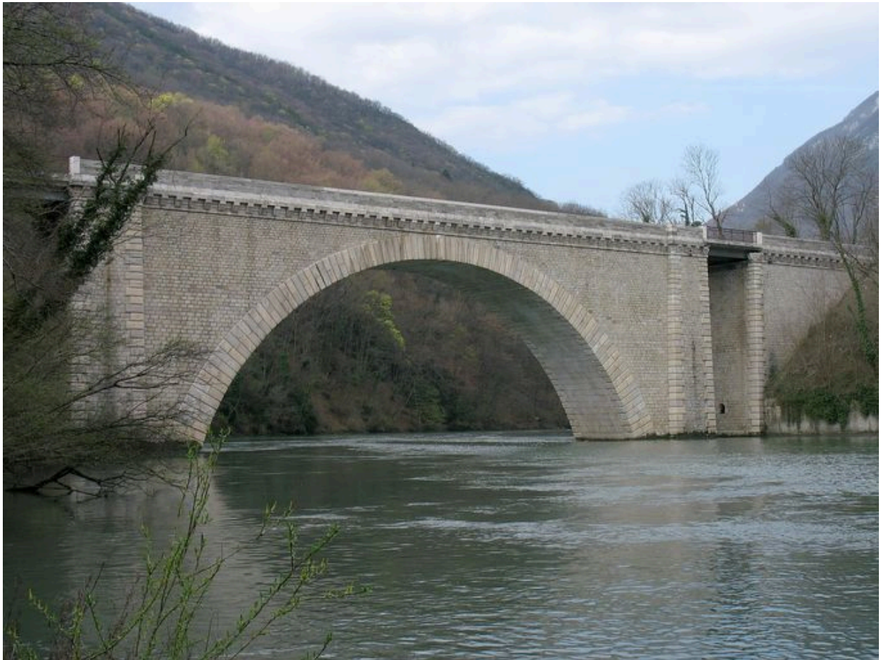
Vue de face de l'arche centrale, côté amont (depuis la rive gauche)
