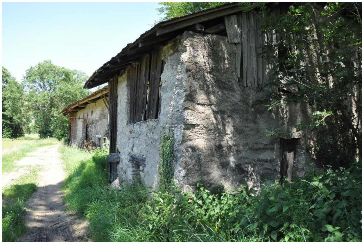
Pignon sud-ouest du bâtiment.
