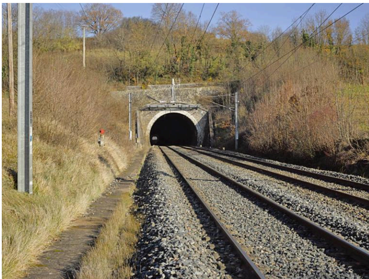
Tunnel à l'est de Randan.
