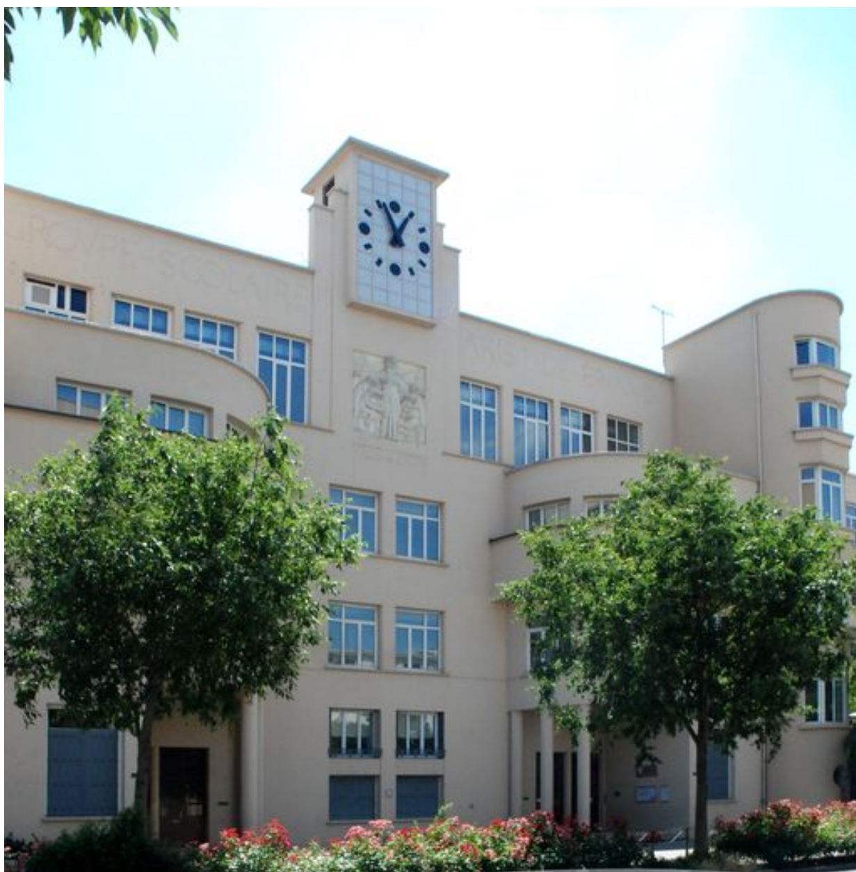
Elévation sur rue, vue de trois-quarts sur la partie centrale
