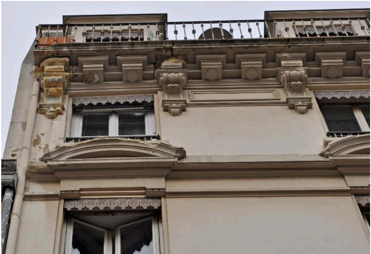
Elévation sur la rue Pasteur, détail du couronnement
