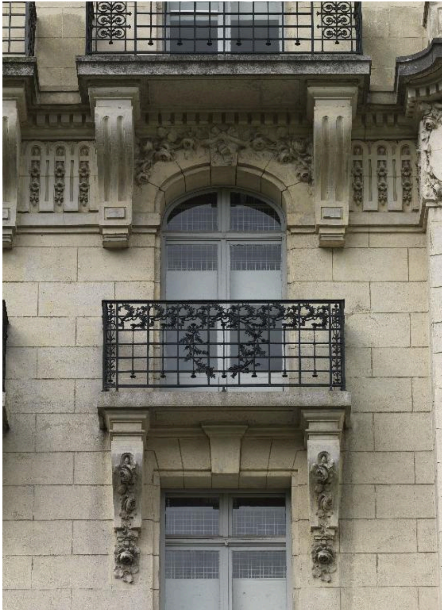
Façade sur cour: baie du 3e étage
