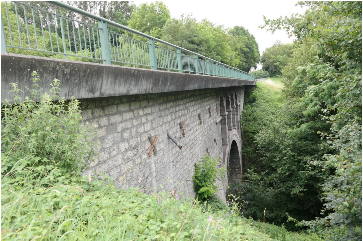
Pont de Gerbaz, vue de la face aval
