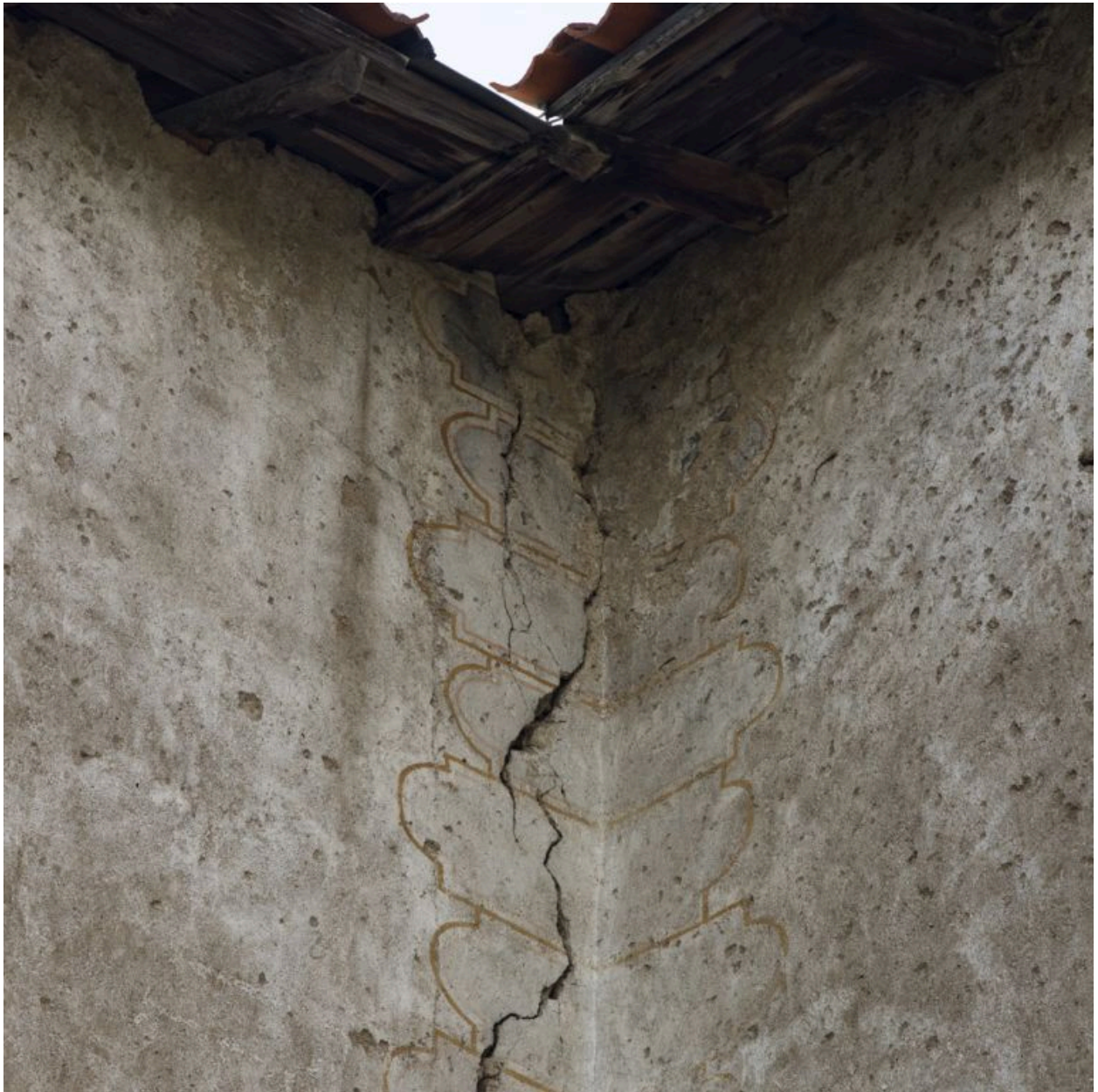
Corps de bâtiment nord et est de la maison forte, angle rentrant au niveau du comble à surcroît, détail du décor peint des chaînages d'angles.
