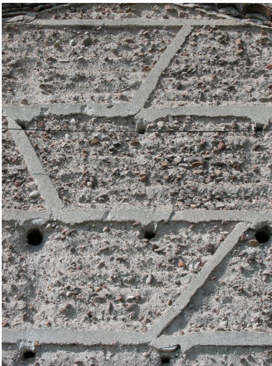
Grange-étable, détail de la mise en oeuvre du pisé.
