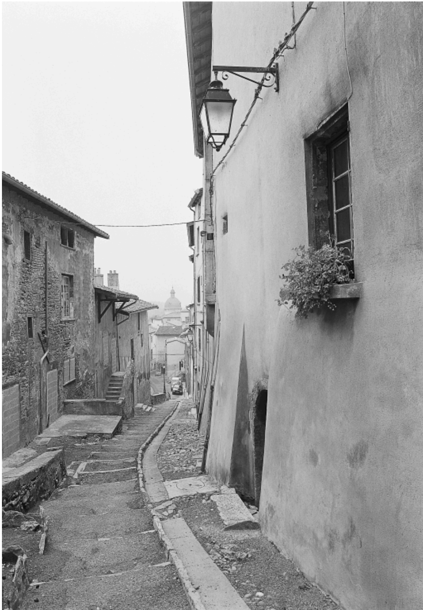
Vue partielle de l'élévation sur la rue Casse-cou (1er. à gauche).
