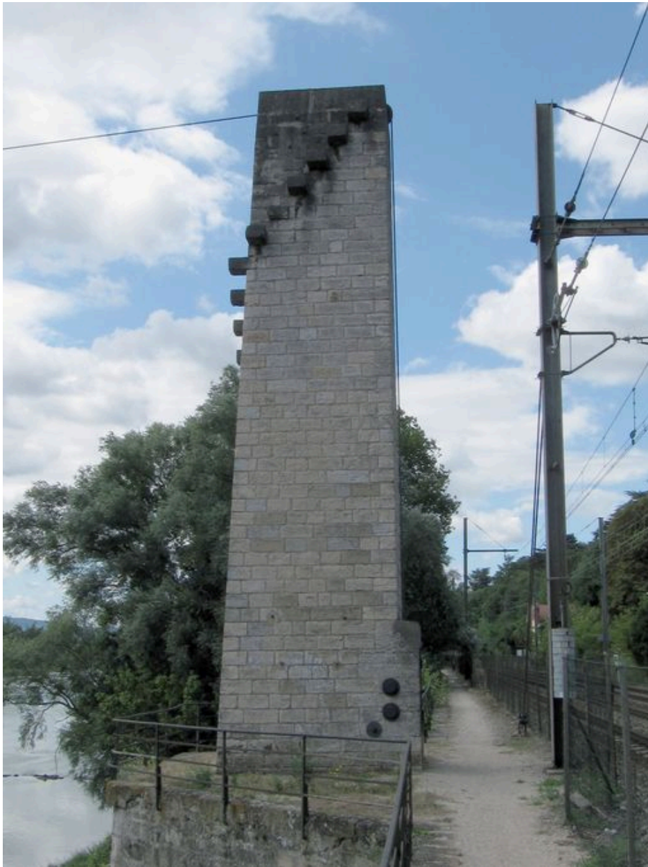
Pile droite, face nord, vue générale (depuis la rive droite)
