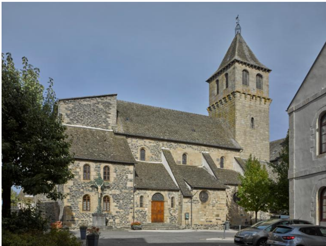
Vue de la façade méridionale de l'église
