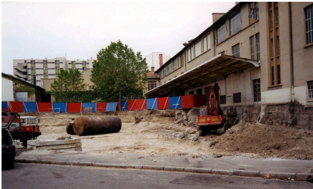
Vue des travaux dans la cour, juillet 1993
