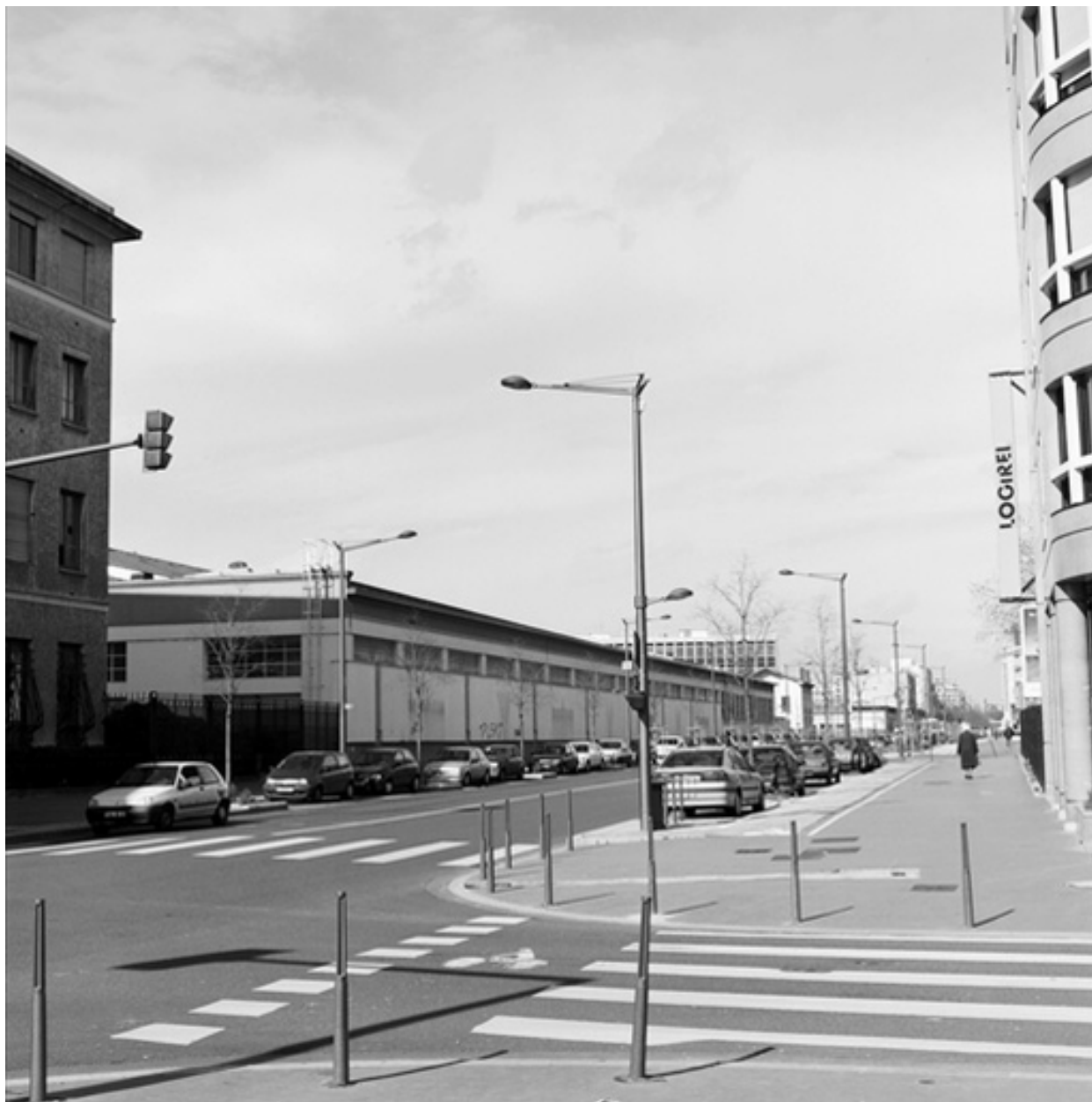
Vue d'ensemble sud avenue Jean-Jaurès
