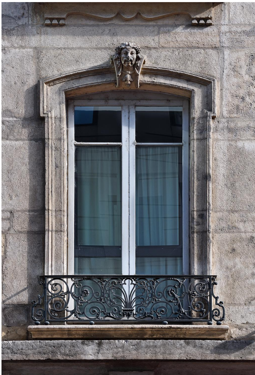
Détail d'une baie du premier étage carré
