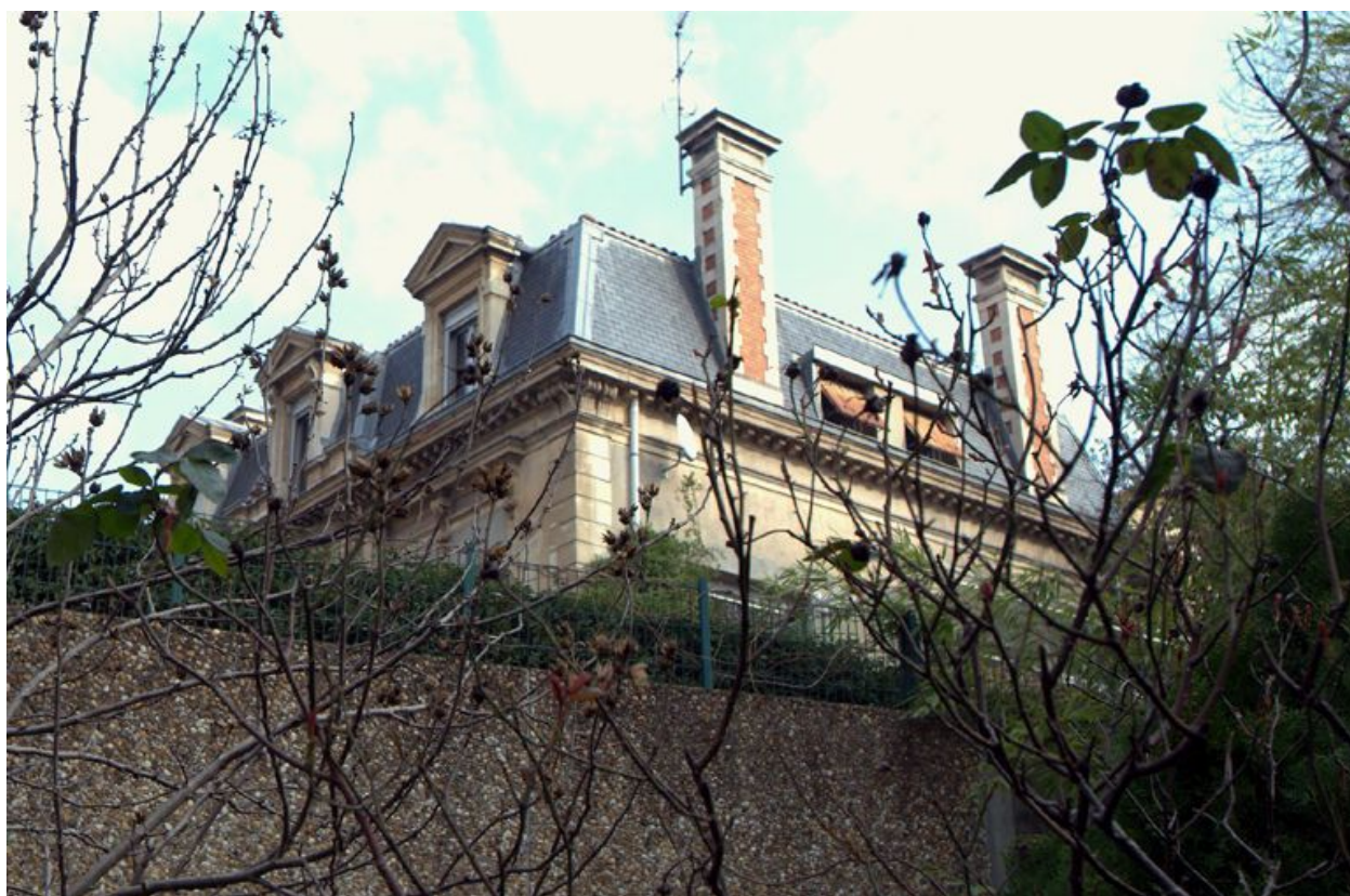
Etage de comble, vue partielle
