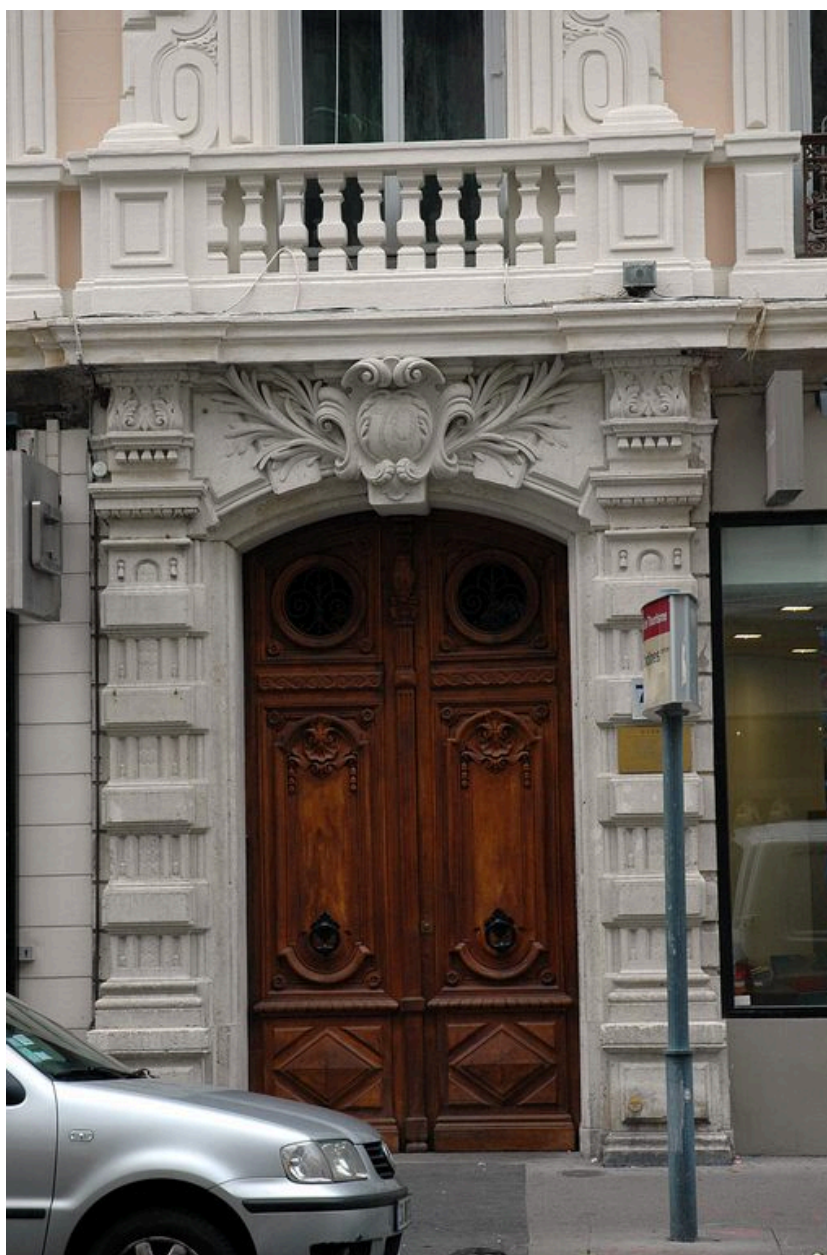
Elévation principale : la porte
