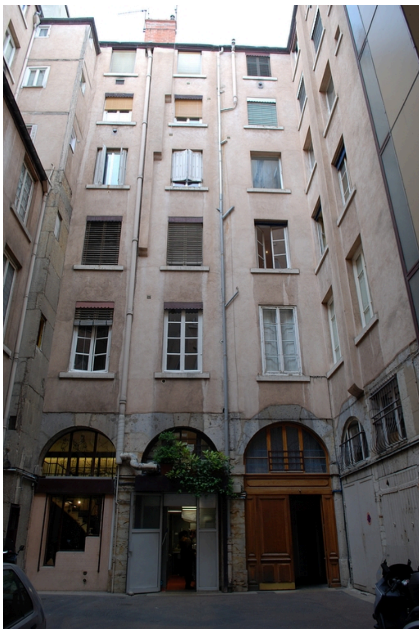
La cour principale : élévation nord
