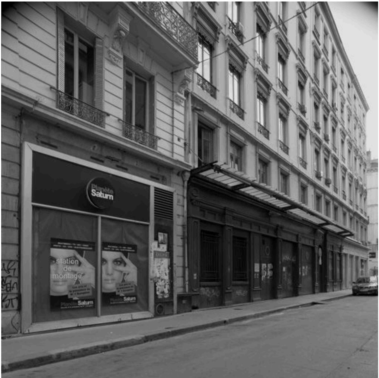
38 rue Tupin : vue d'ensemble du rez-de-chaussée depuis l'est
