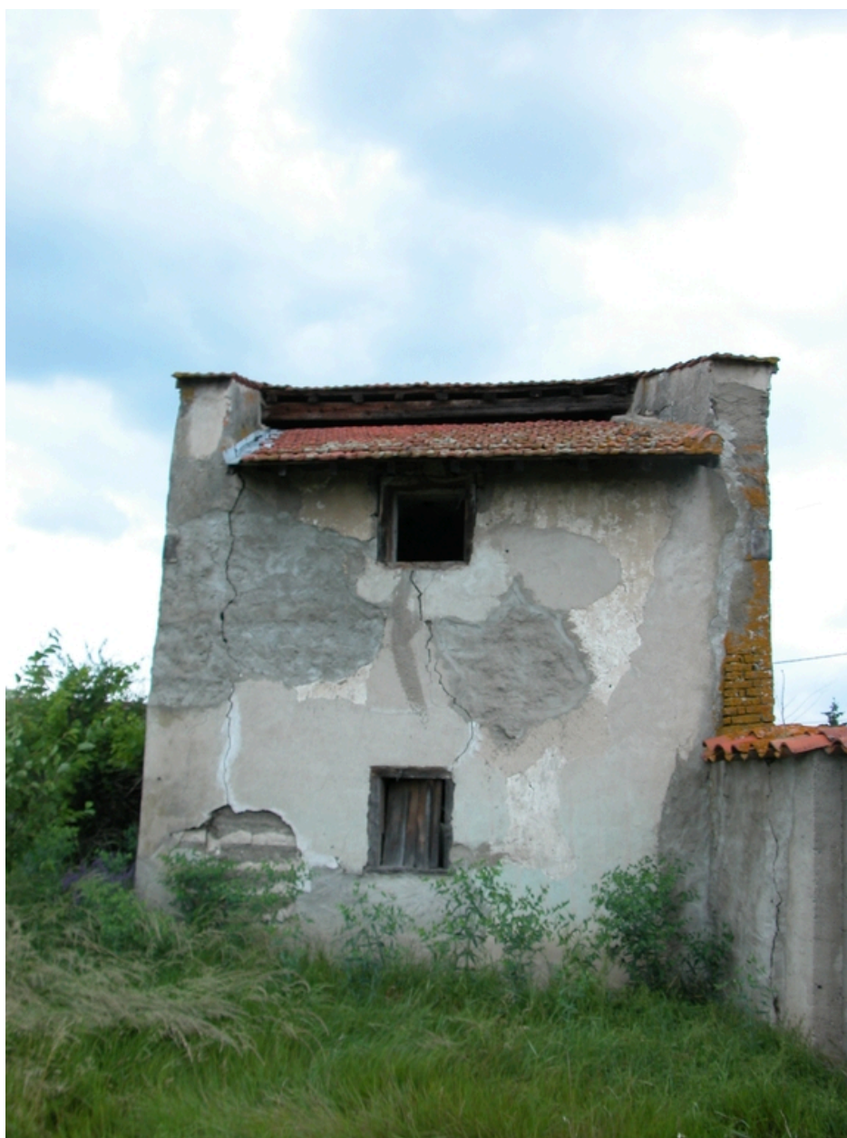
Vue d'ensemble de l'élévation est.
