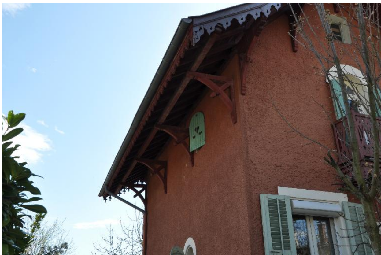
Détail sur les lambrequins des rives de toit
